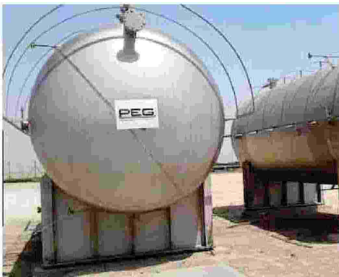
Peg progetta e costruisce impianti per trattare petrolio e gas
